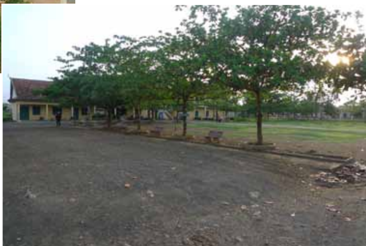
Arbetet med markutfyllnad har påbörjats.
